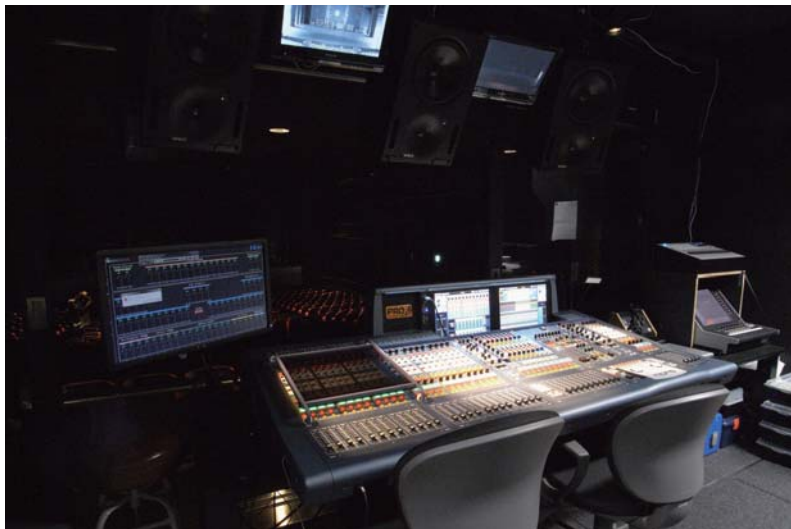
音響調整室内
