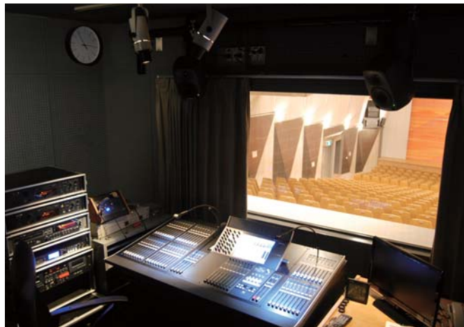
大ホール 音響調整室内
