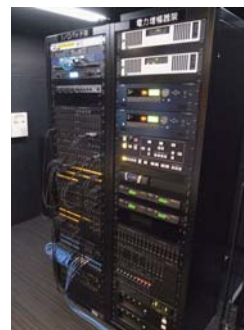
左から : 1/0 パッチ架、電力増幅器架
